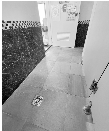
↑ 充實及改善學習環境設施設備—修繕班級廁所地磚工程
