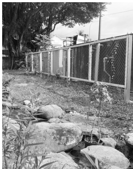
↑ 校園建築空間運用及美化綠化環境—增設「水生植物池畔生態綠牆設施工程」
