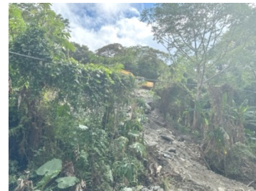
圖 8：約距西林林道入口 5K 處，道路崩塌修復中。
