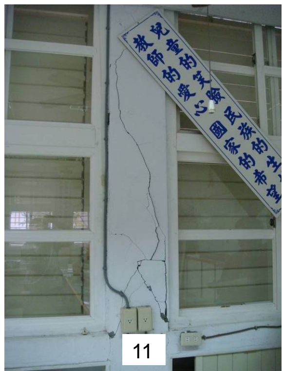
圖 5.80 台東三間國小教學行政大樓窗台柱 11、12 一樓室內實際裂縫開裂情形
