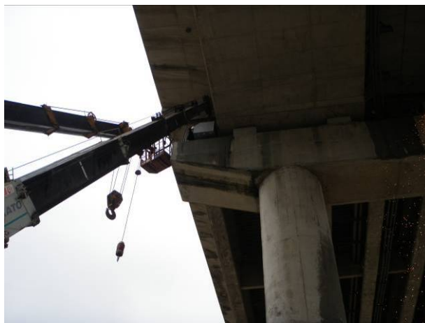
圖 6.37 P4 橋墩變位限制裝置現場吊裝 (資料來源：建業工程顧問有限公司)
