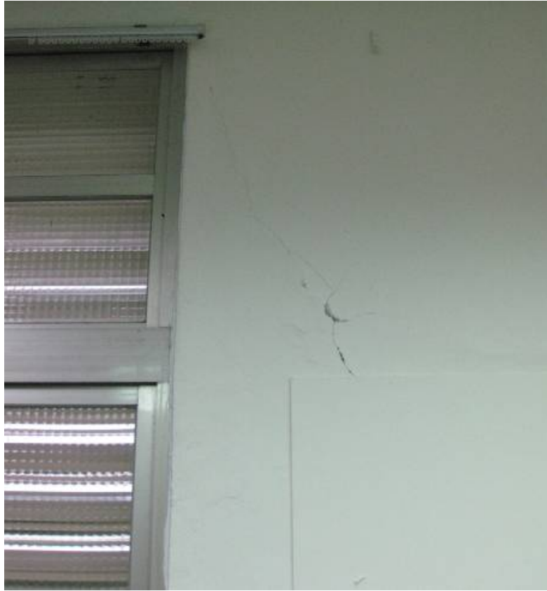
圖 5.66 新社國小北棟校舍二樓校長室內牆
