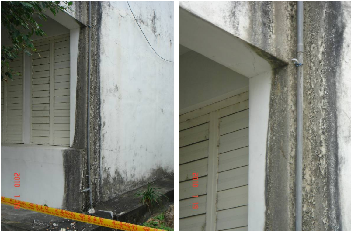
圖 5.14 磯崎分校教學教室 D1 柱無明顯破壞，梁底有細微裂縫寬度 0.5mm。
