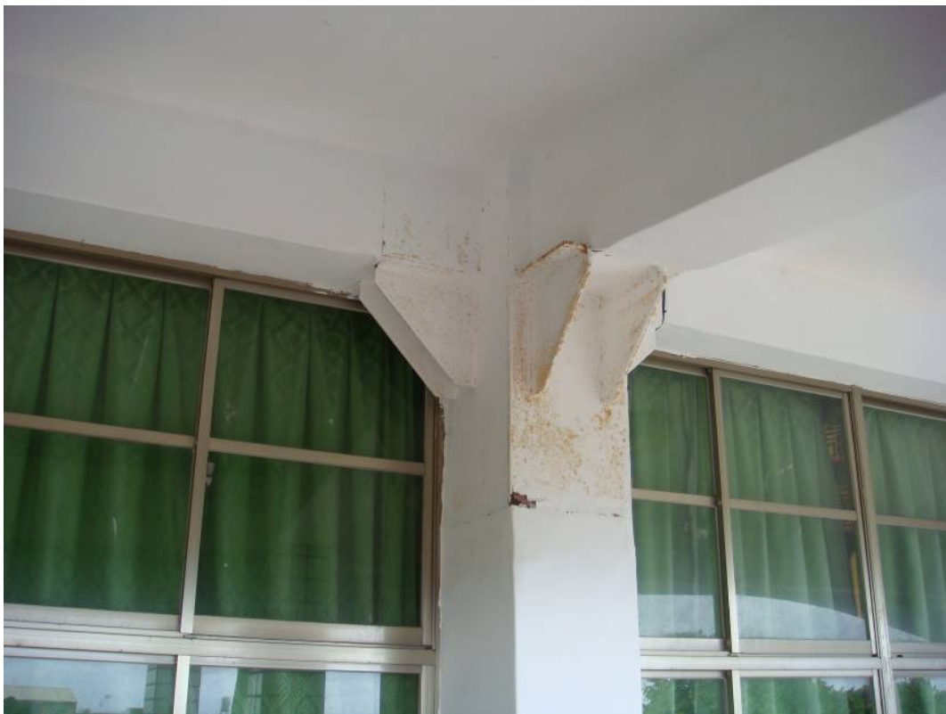
圖 5.106 信義國小教學大樓先前梁柱接頭鋼板補強情形（二）
