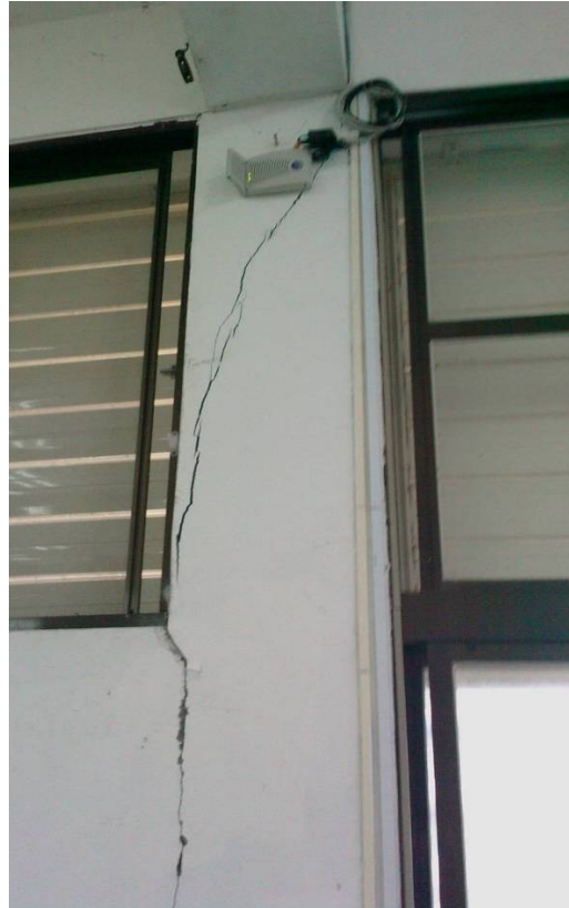
圖 5.27 月眉國小專科教室西南側氣窗短柱剪力破壞照片， 裂縫寬度達 5mm
