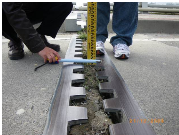
圖 6.16 P4 伸縮縫 S5 跨側較 S4 跨側高約 2cm (資料來源：偉蟲工程顧問有限公司)
