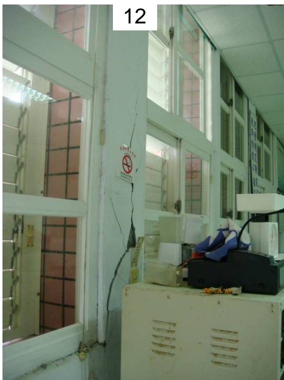
圖 5.80 台東三間國小教學行政大樓窗台柱 11、12 一樓室內實際裂縫開裂情形
