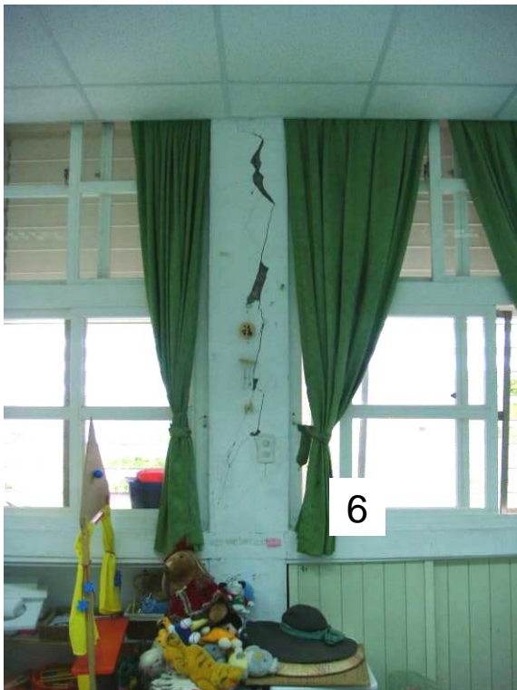
圖 5.78 台東三間國小教學行政大樓窗台柱 6、7 一樓室內實際裂縫開裂情形
