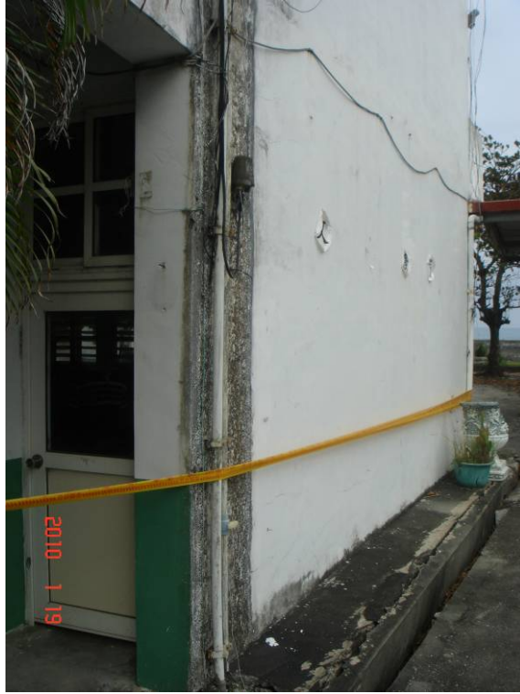
圖 5.13 磯崎分校教學教室 B7 柱無明顯破壞。
