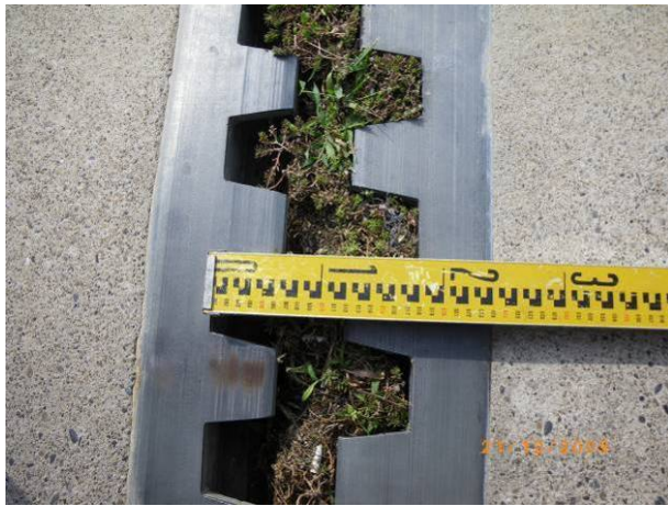
圖 6.12 P4 伸縮縫(指鈹根-指鈹根)間距約 18cm (資料來源：偉蟲工程顧問有限公司)
