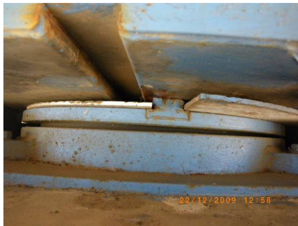
圖 6.21 P4-2 盤式支承上盤與導桿脫離並向右側側移 (資料來源：偉蟲工程顧問有限公司)
