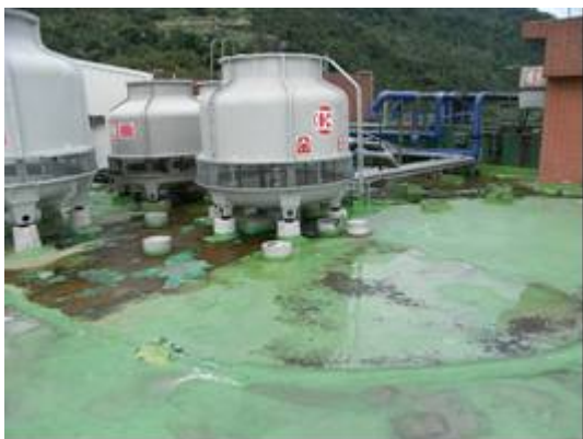
圖 7.26 (a)頂樓冷卻水塔漏水，(b)冷卻水塔隔振橡膠墊滑動痕跡
