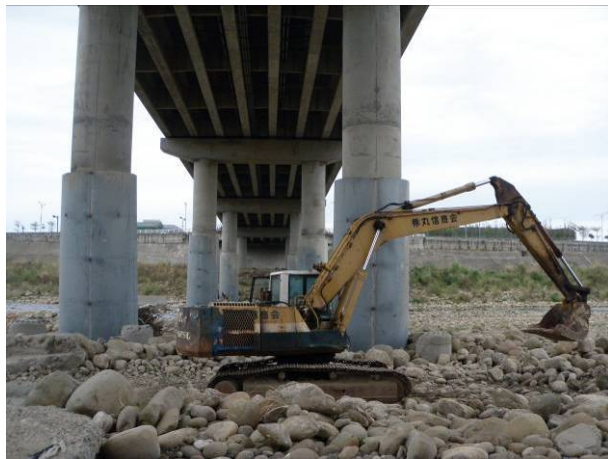
圖 6.18 施工便道整理 (資料來源：建業工程顧問有限公司)
