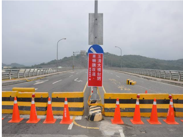
圖 6.11 玉清大橋封橋告示標誌 (98 年 12 月 25 日)
