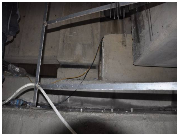
圖 6.33 P4 橋墩預力梁及支承面無損壞
