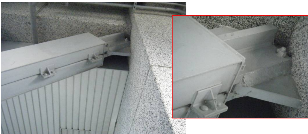
圖 7.32 協力樓一樓 BRB 外觀無損
