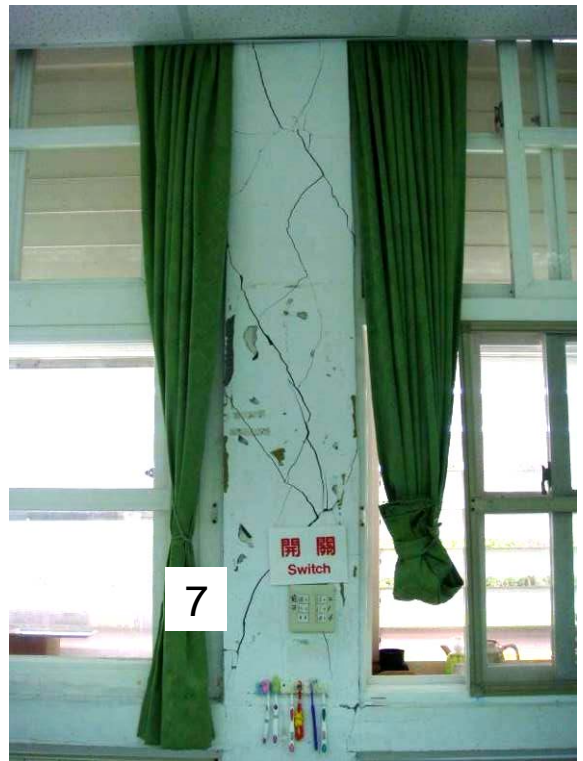
圖 5.78 台東三間國小教學行政大樓窗台柱 6、7 一樓室內實際裂縫開裂情形
