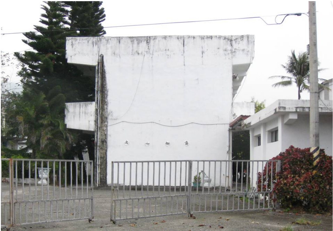
圖 5.5 磯崎分校教學教室側面立面照片
