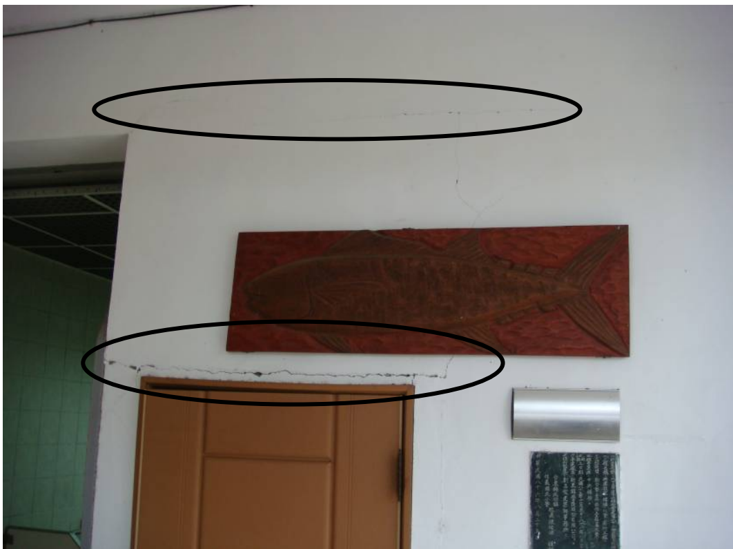
圖 5.110 信義國小教學大樓北側一樓廁所走廊側牆門上方及與梁接面處開裂
