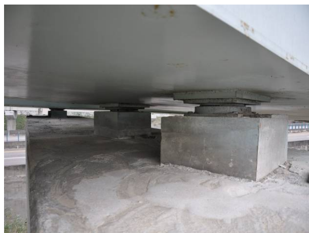
圖 6.34 閘道橋墩盤式支承無損壞
