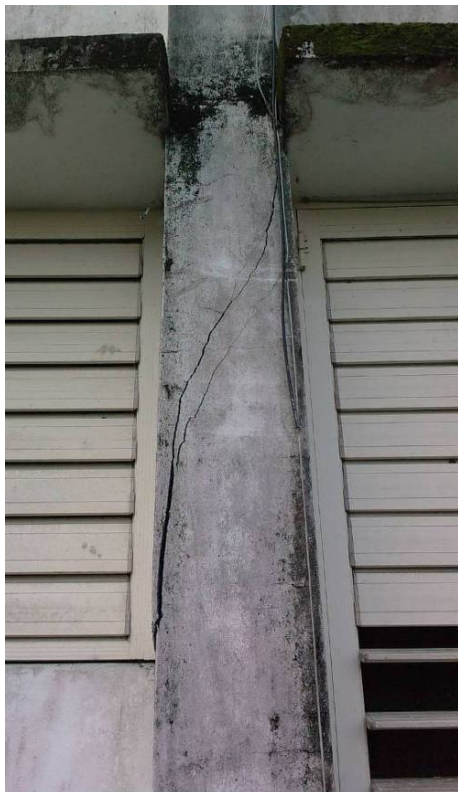
圖 5.28 月眉國小專科教室東北側氣窗短柱剪力破壞照片， 裂縫寬度達 10mm
