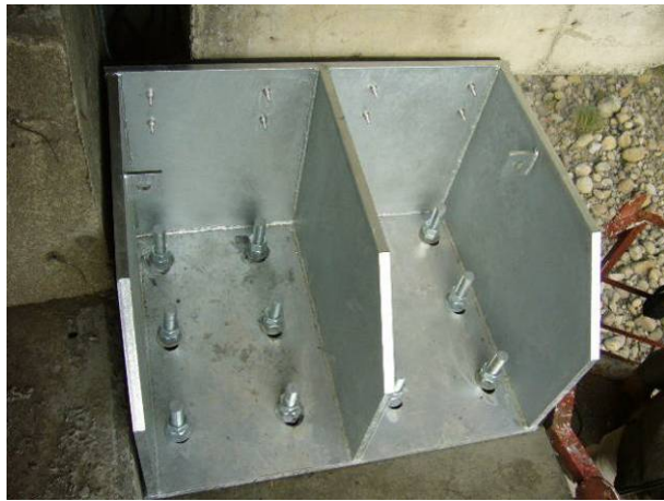
圖 6.39 P4-2 支承側邊變位限制裝置錨栓固定 (資料來源：建業工程顧問有限公司)
