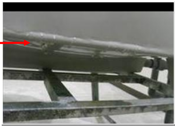
圖 7.16 儲水槽漏水
