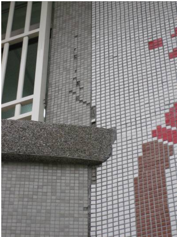
圖 5.35 水璉國小圖書館外側牆面裂縫
