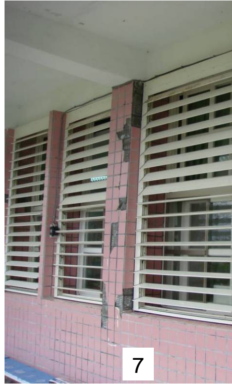
圖 5.77 台東三間國小教學行政大樓窗台柱 6、7 一樓室外實際裂縫開裂情形
