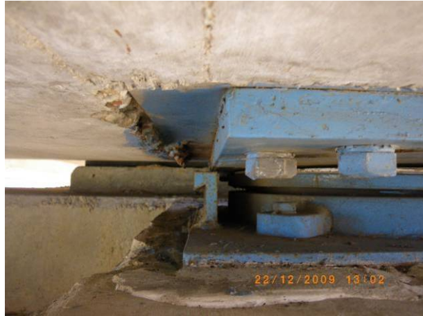
圖 6.23 P4-2 盤式支承上盤角鐵斷裂損壞 (資料來源：偉蟲工程顧問有限公司)
