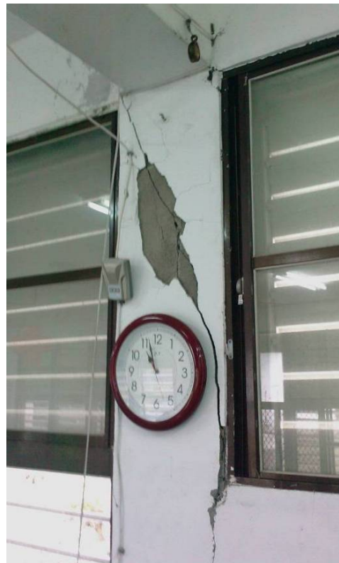
圖 5.28 月眉國小專科教室東北側氣窗短柱剪力破壞照片， 裂縫寬度達 10mm
