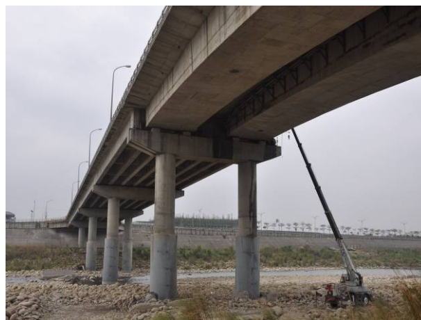
圖 6.3 玉清大橋引道橋 P4 橋墩
