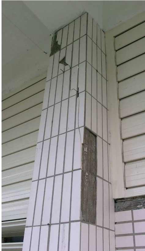
圖 5.27 月眉國小專科教室西南側氣窗短柱剪力破壞照片， 裂縫寬度達 5mm
