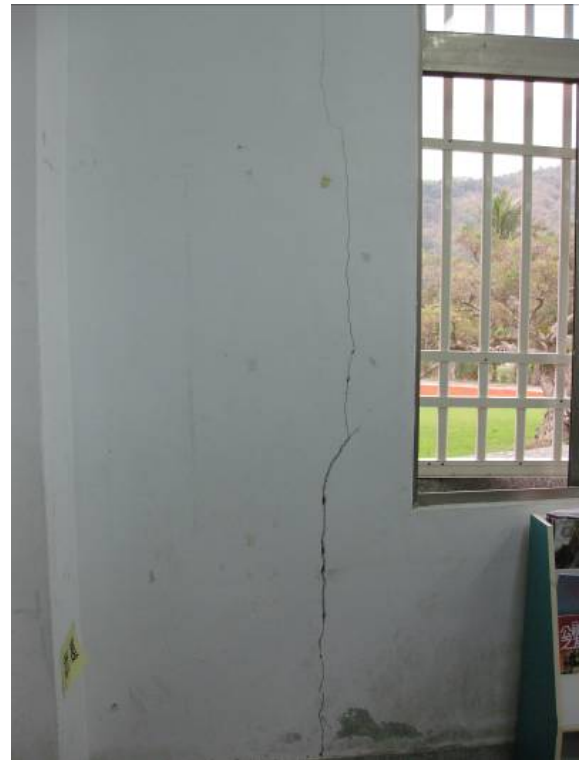
圖 5.35 水璉國小圖書館外側牆面裂縫
