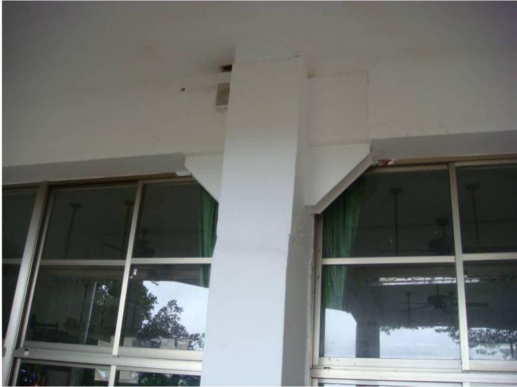
圖 5.105 信義國小教學大樓先前梁柱接頭鋼板補強情形（一）
