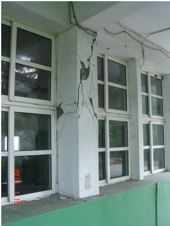
圖 5.12 磯崎分校教學教室 B6 柱明顯剪力破壞，裂縫寬度達 8mm，並有局部混凝土塊剝落，柱主筋裸露。
