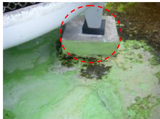
圖 7.26 (a)頂樓冷卻水塔漏水，(b)冷卻水塔隔振橡膠墊滑動痕跡
