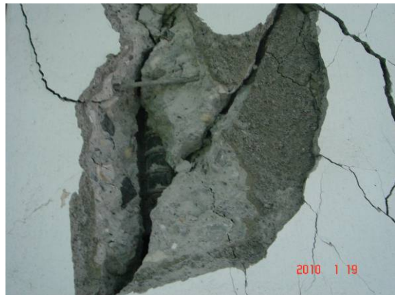
圖 5.12 磯崎分校教學教室 B6 柱明顯剪力破壞，裂縫寬度達 8mm，並有局部混凝土塊剝落，柱主筋裸露。
