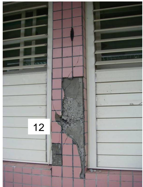
圖 5.79 台東三間國小教學行政大樓窗台柱 11、12 一樓室外實際裂縫開裂情形
