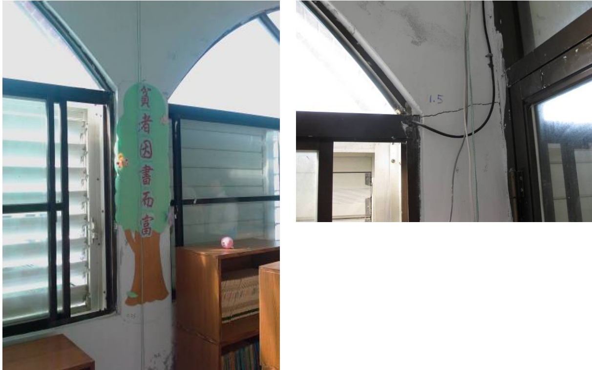
圖 5.29 月眉國小專科教室懸臂走廊上方二樓磚牆受損情形， 裂縫寬度達 1.5mm
