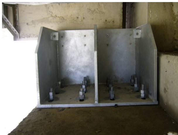
圖 6.40 P4-3 支承側邊變位限制裝置安裝完成 (資料來源：建業工程顧問有限公司)
