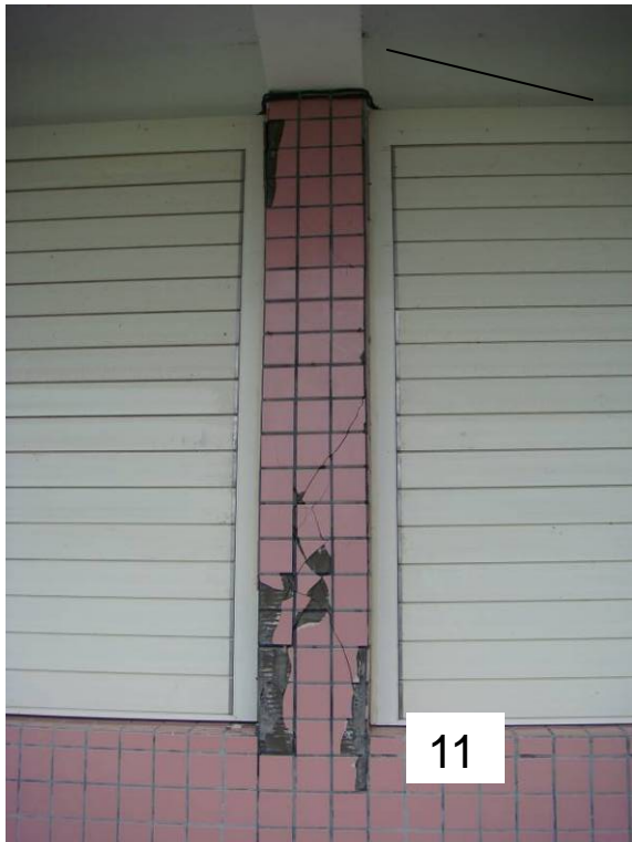
圖 5.79 台東三間國小教學行政大樓窗台柱 11、12 一樓室外實際裂縫開裂情形
