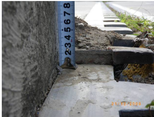
圖 6.15 P4 伸縮縫右側單元較左側單元高約 2cm (資料來源：偉蟲工程顧問有限公司)
