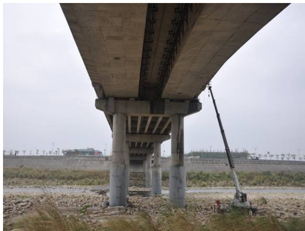
圖 6.19 高空檢測作業
