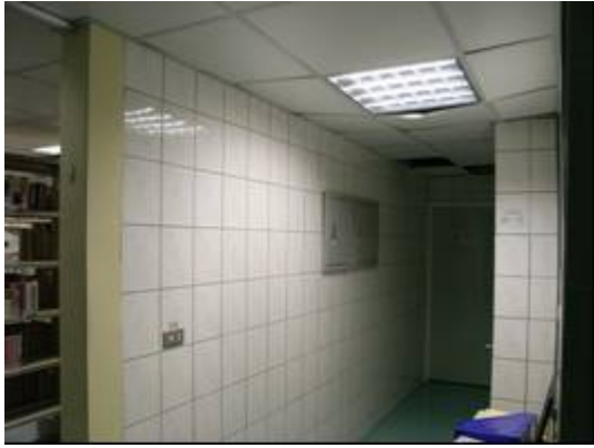
圖 7.22 圖書館服務間天花板產生面外隆起破壞與掉落
