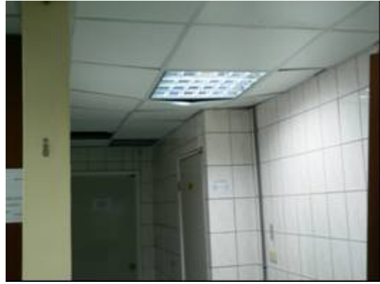
圖 7.22 圖書館服務間天花板產生面外隆起破壞與掉落
