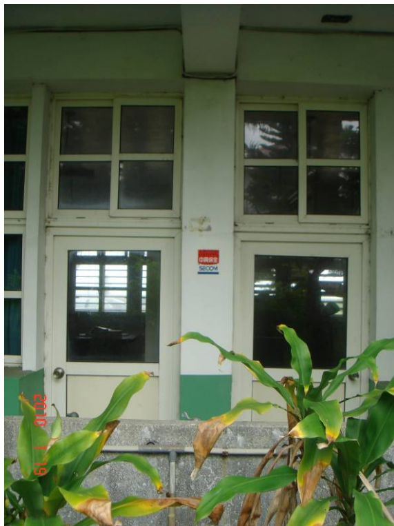
圖 5.11 磯崎分校教學教室 B5 柱無明顯破壞。
