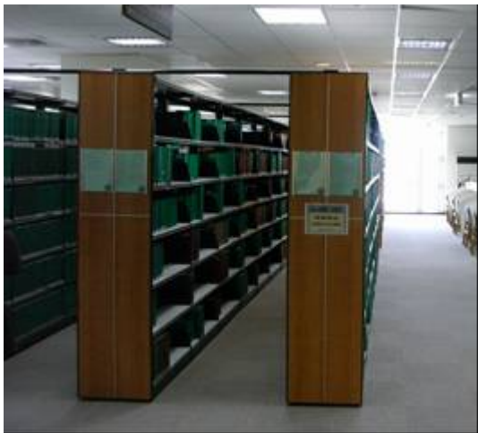
圖 7.8 (a)圖書架與橫向連桿，(b)橫向連桿與書架固定方式細部
