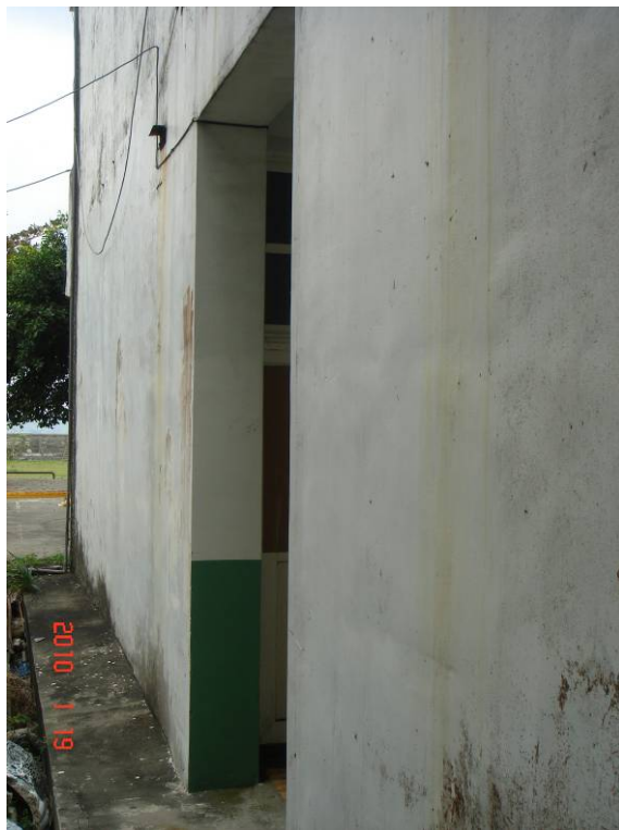
圖 5.7 磯崎分校教學教室 B1 柱無明顯破壞。
