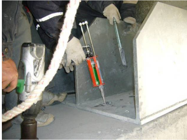
圖 6.38 P4-2 支承變位限制裝置灌注錨栓化學藥劑 (資料來源：建業工程顧問有限公司)
