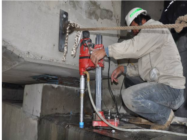
圖 6.35 P4 橋墩變位限制裝置螺栓孔定位
