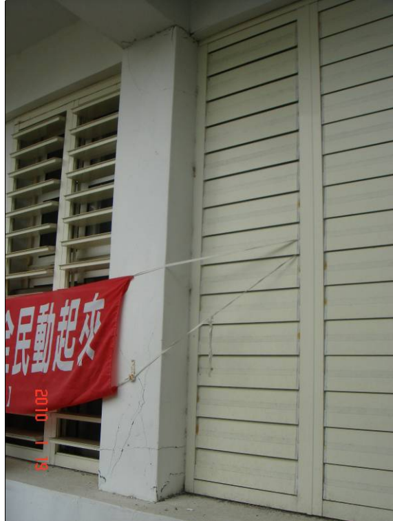
圖 5.17 磯崎分校教學教室 D4 柱明顯剪力破壞，裂縫寬度達 1mm。
