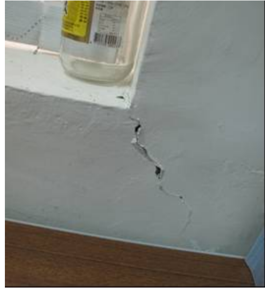
圖 7.24 圖書室窗檯邊牆面出現垂直與 45 度斜向裂縫
