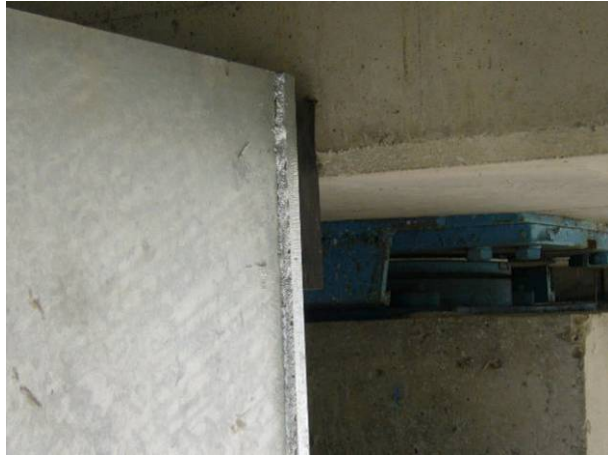
圖 6.41 P4-2 支承與防撞鋼板相對位置 (資料來源：建業工程顧問有限公司)
