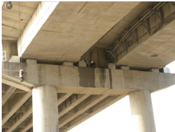
圖 6.42 防撞鋼板安裝完成 (資料來源：建業工程顧問有限公司)
