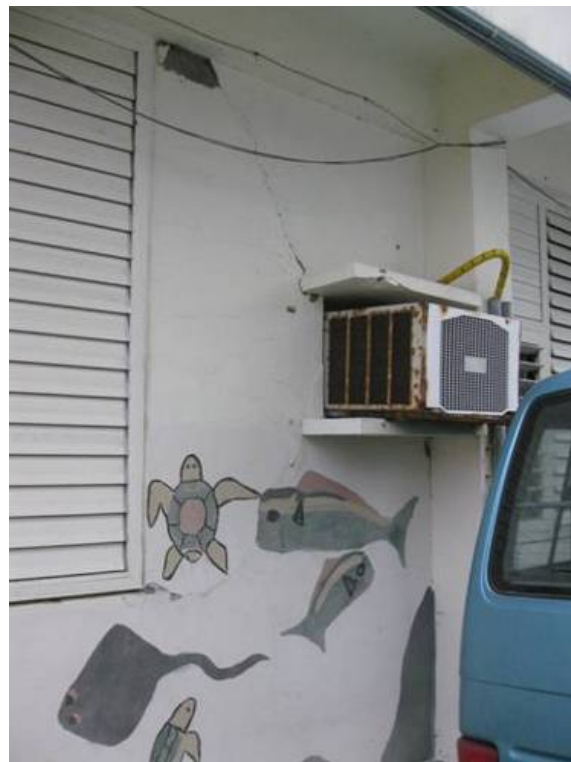
圖 5.65 新社國小北棟校舍一樓電腦教室外牆
