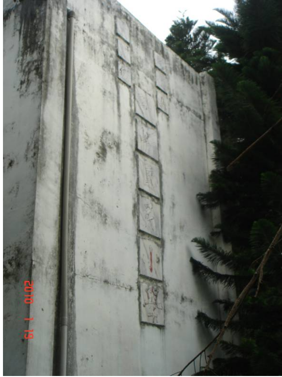
圖 5.6 磯崎分校教學教室 A1 及 A2 柱無明顯破壞。
