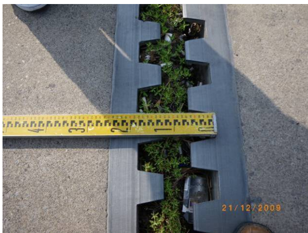
圖 6.13 P7 伸縮縫(指鈹根-指鈹根)間距約 18cm (資料來源：偉蟲工程顧問有限公司)
